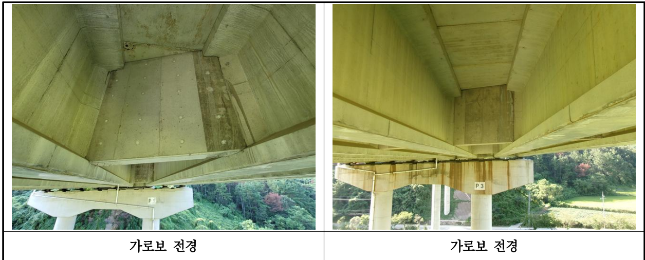
【사진 8.3.6】 가로보 전경
