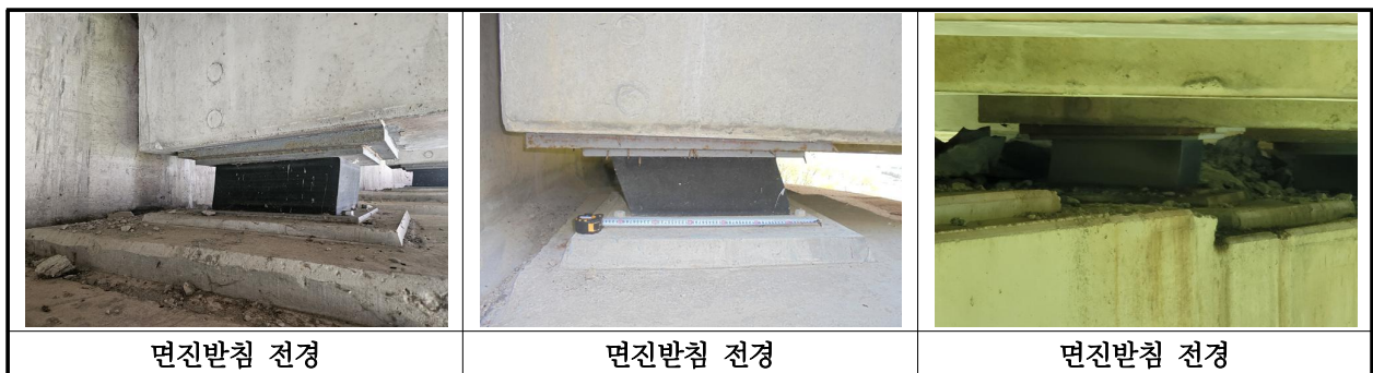
【사진 8.3.13】 교량받침 전경
