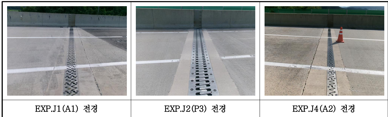
【사진 8.3.17】 신축이음장치 전경
