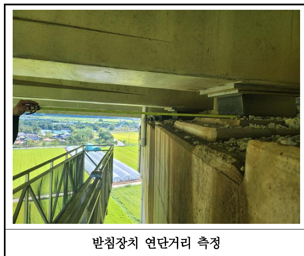
【사진 8.3.15】 교량받침장치 연단거리측정
