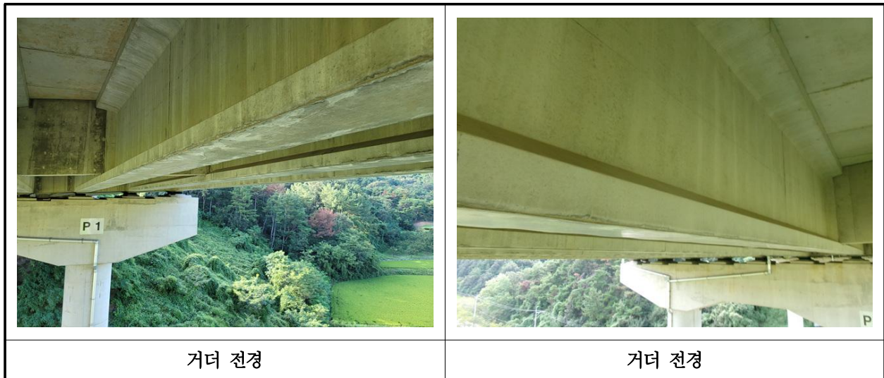
【사진 8.3.4】 거더 전경
