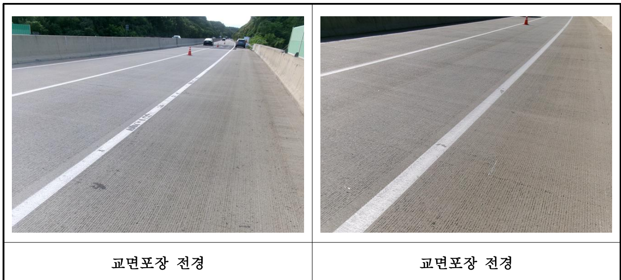
【사진 8.3.20】 교면포장 전경
