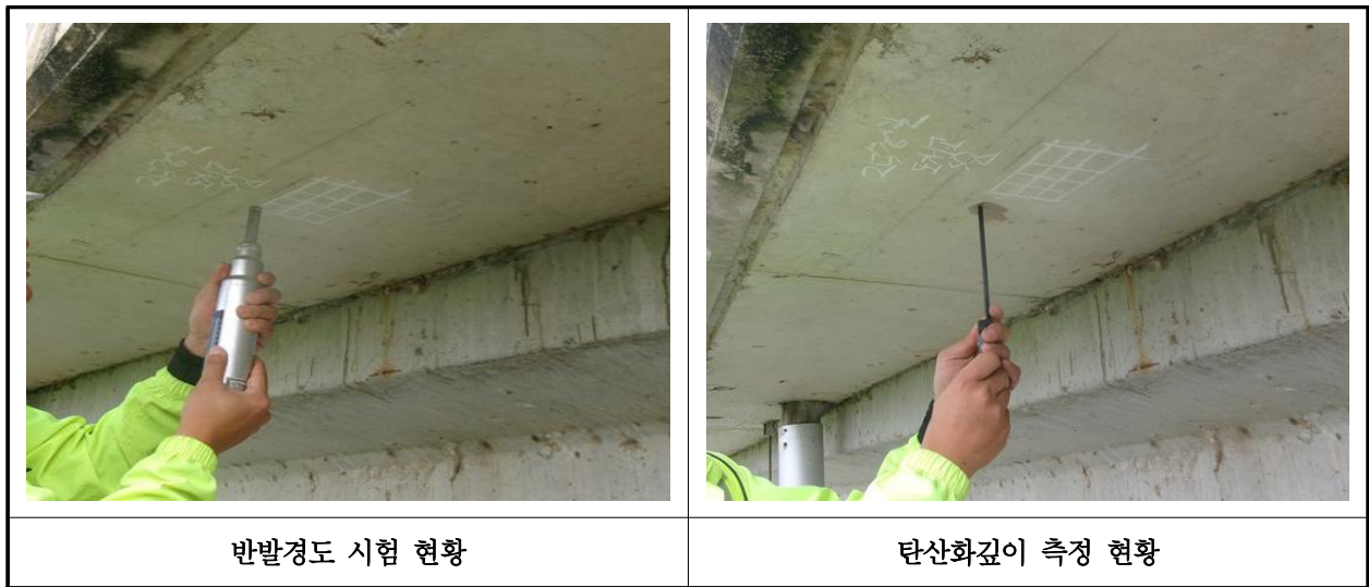
【사진 8.4.1】 콘크리트 내구성조사 현황
