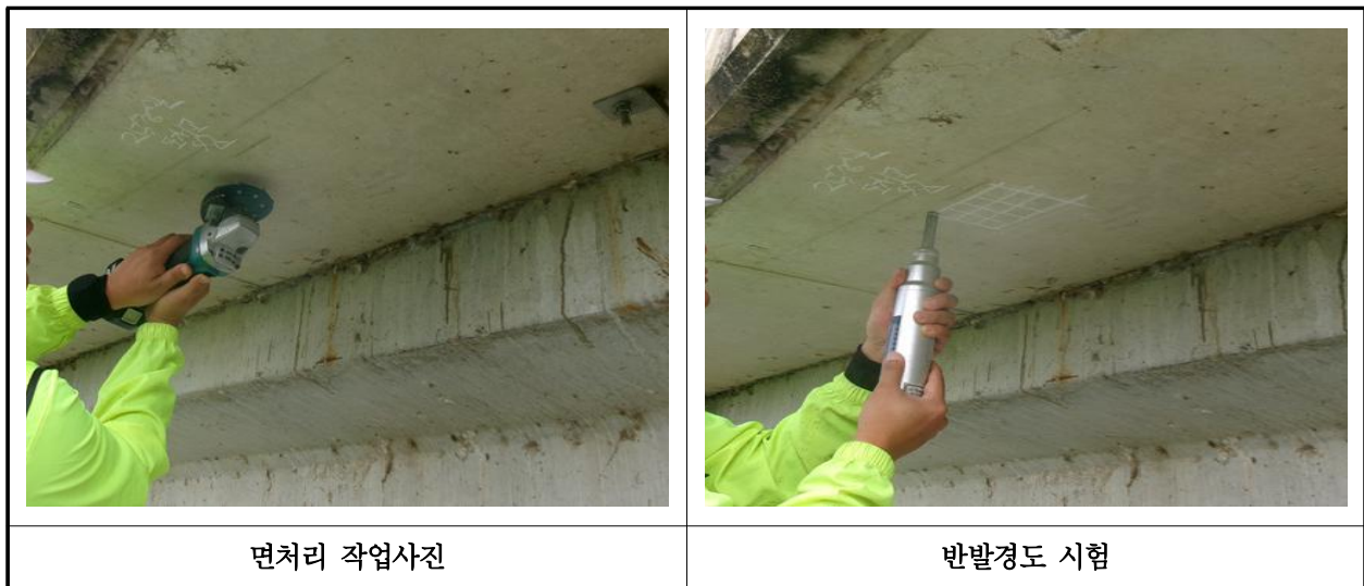
【사진 8.4.2】 반발경도시험 현장사진
