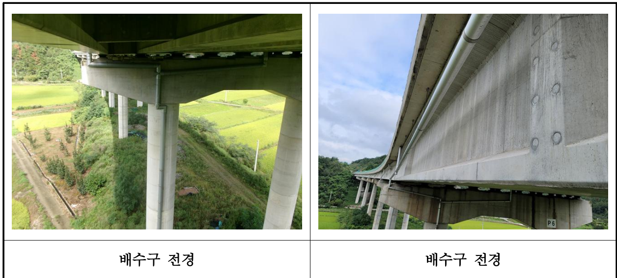
【사진 8.3.22】 배수시설 전경
