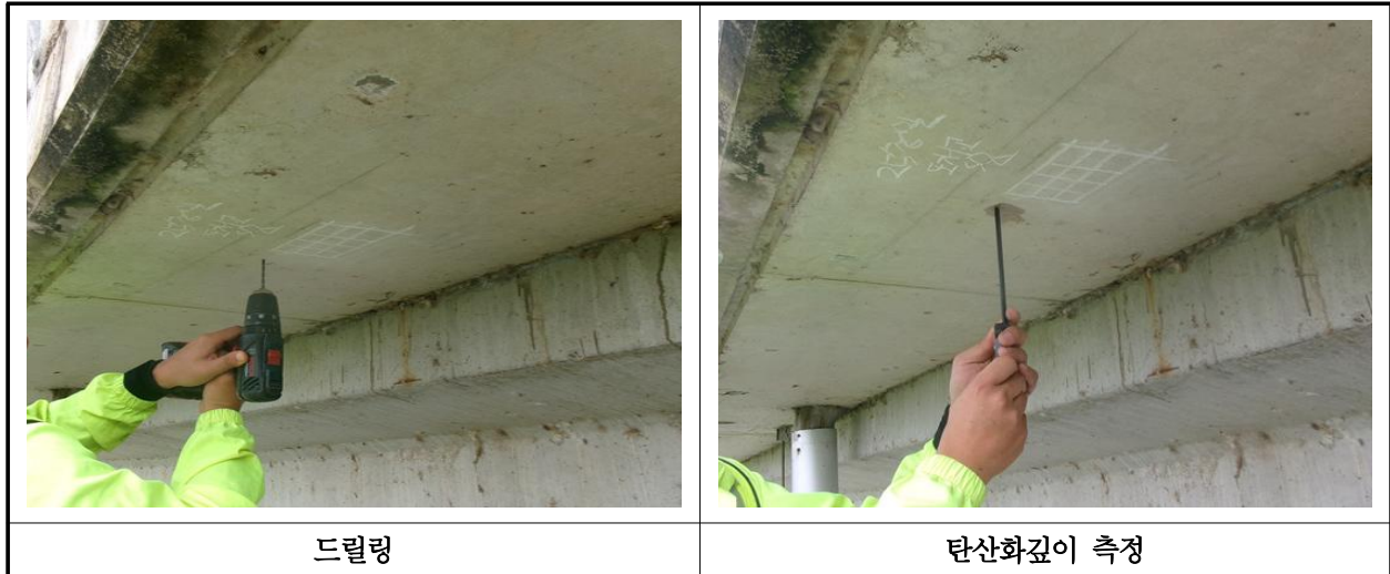
【사진 8.4.3】 탄산화 깊이 측정 현장사진
