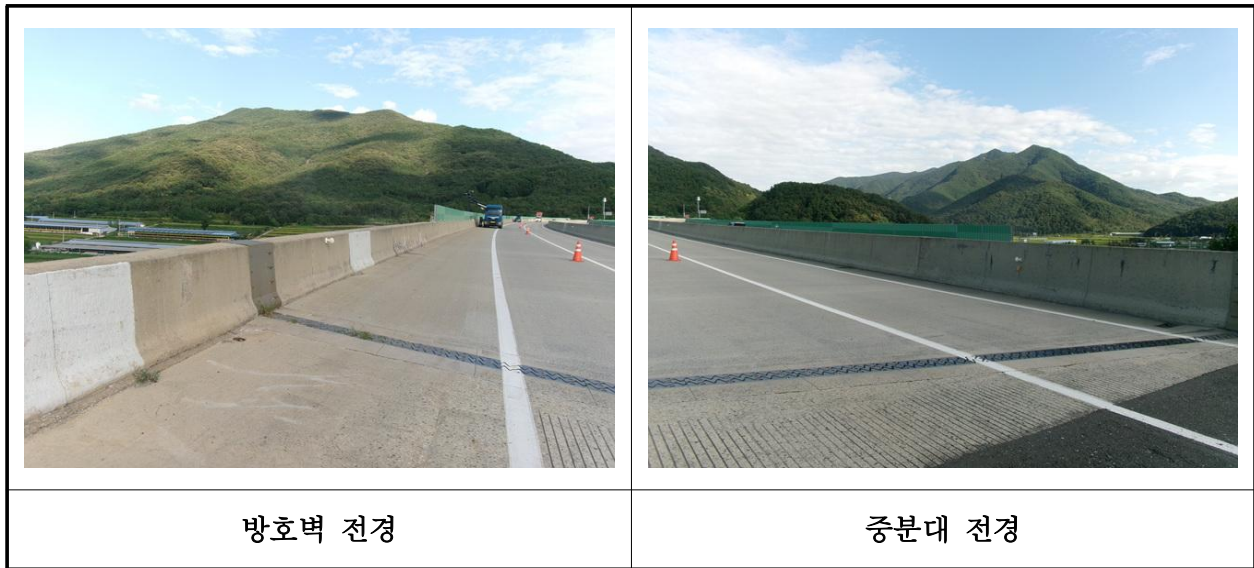
【사진 8.3.24】 방호벽 및 중앙분리대 전경
